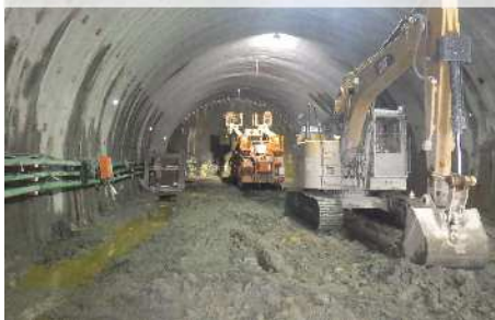
【山岳トンネル部施工状況】
