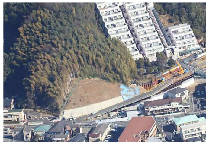
写真① 土留め・仮橋の状況
