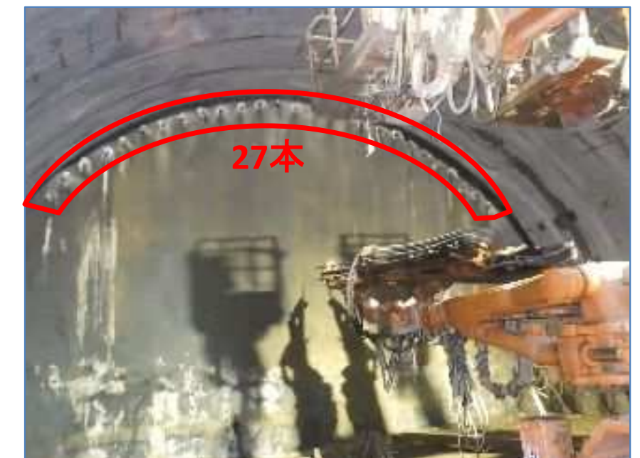
補助工法の施工状況
