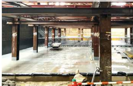
【開削トンネル部施工状況】
