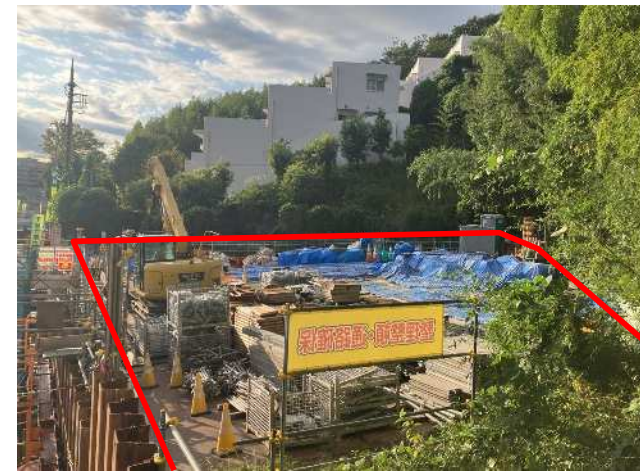
写真③ 資材ヤードの借地の状況
