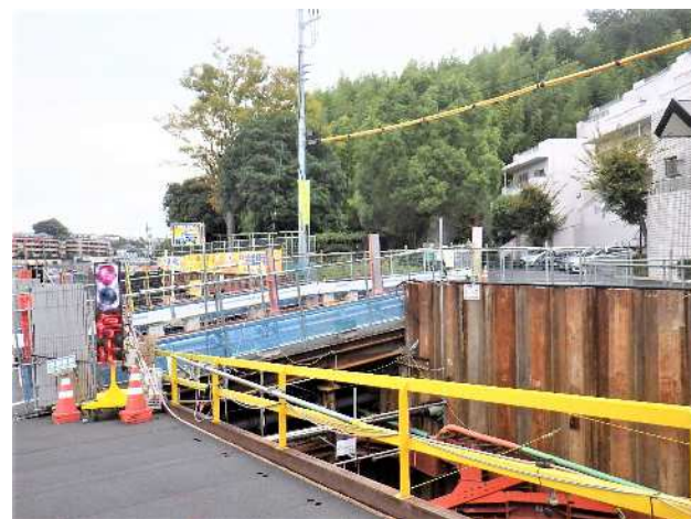
写真② マンションへの仮設橋りょうの状況
