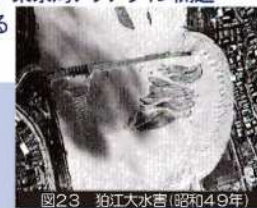
図23 狛江大水害(昭和49年)
