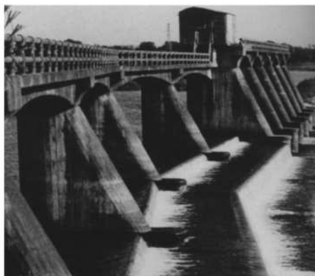
昭和20(1945)年 竣工の上河原堰
