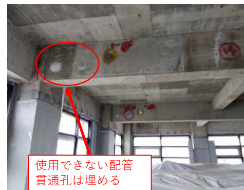
【設計図と異なる配管貫通孔の数】
