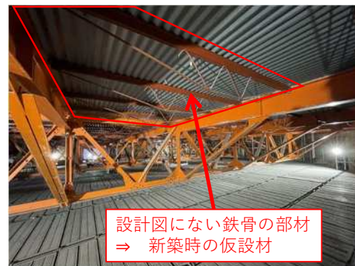
【②－3：大ホール屋根鉄骨梁の違い】
