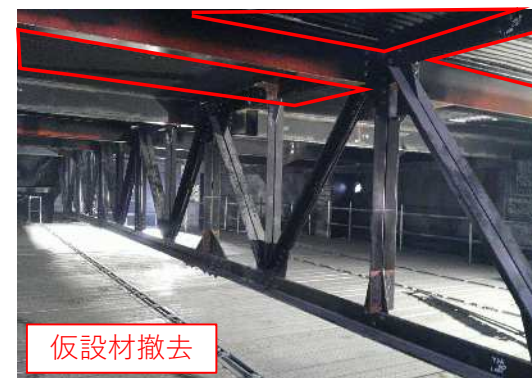
【仮設材撤去状況】
