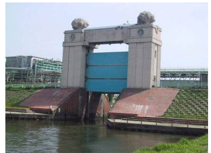
川崎河港水門
