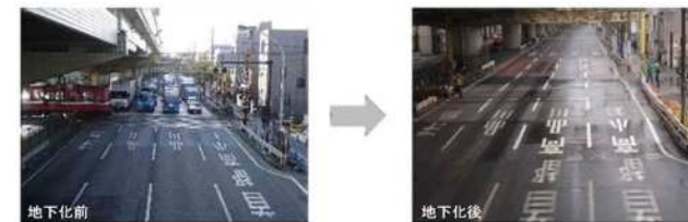
産業道路における踏切の除却
