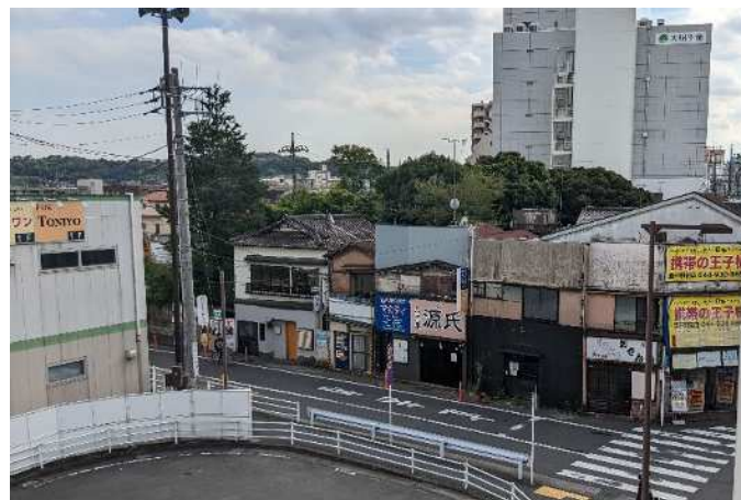
区画整理事業着手前（令和2年9月）
