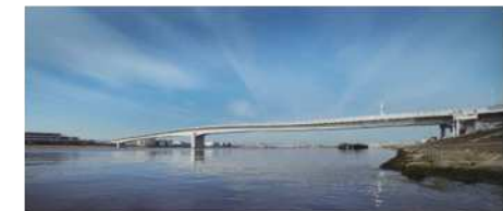
多摩川スカイブリッジ
