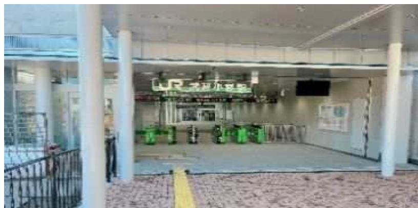
JR武蔵小杉駅綱島街道口
