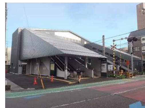
橋上駅舎化されたJR稻田堤駅
