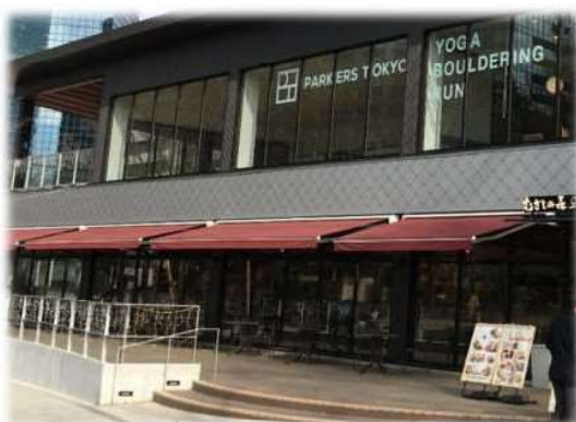
建物の低・中層部がガラス面
