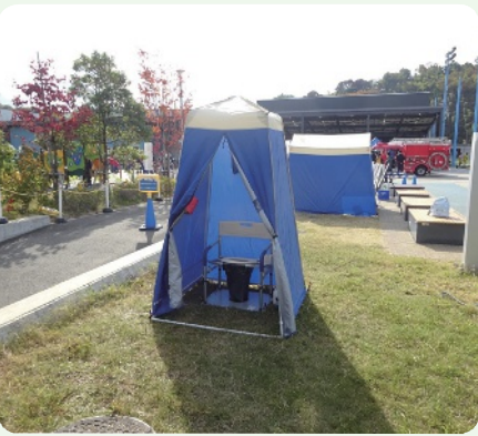
マンホールトイレ設置の様子
