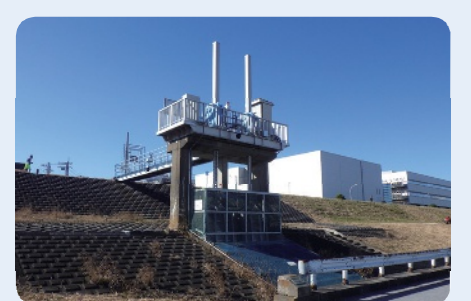
排水樋管の様子
