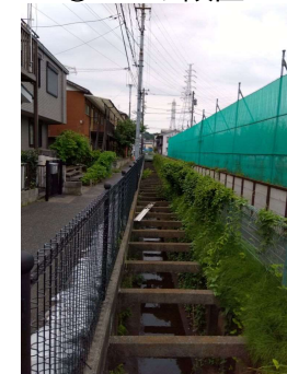
①土のう設置
