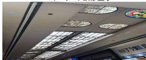
▼アーケード改修工事
