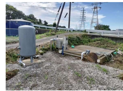
▲改修工事（井戸ポンプ）
