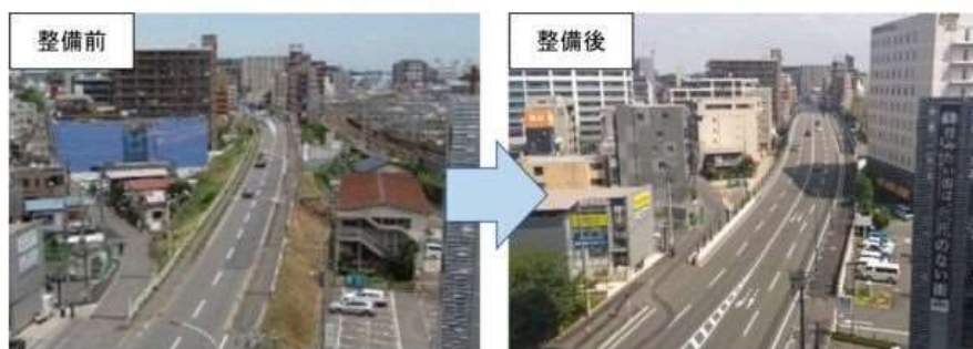
都市計画道路東京丸子横浜線(市ノ坪工区)
