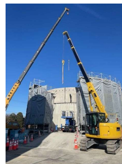
千代ヶ丘配水塔1号塔撤去状況 (令和8(2026)年4月撤去完了)
