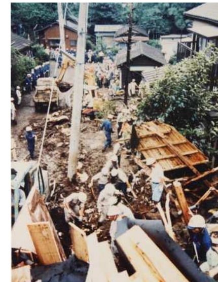
（写真）平成元（1989）年蟹ヶ谷崖崩れ災害
