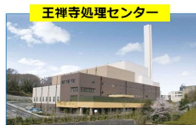
H24年3月竣工
