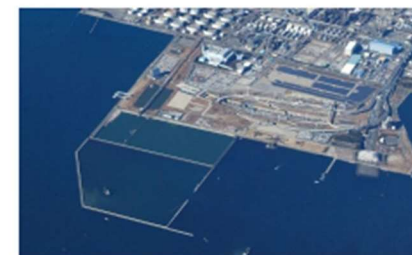
浮島2期廃棄物埋立処分場
