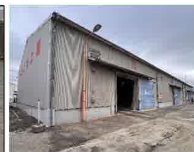
【上屋：屋根・外壁等の改修】
