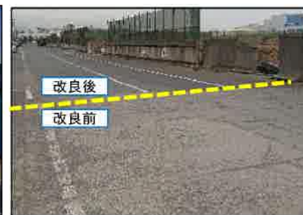
【ふ頭内道路：舗装の打換】
