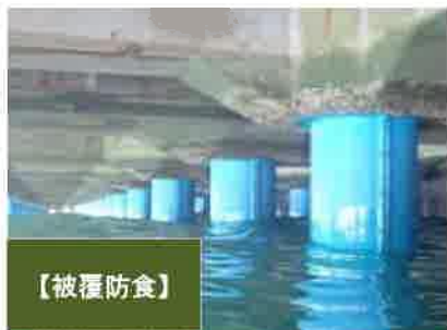
【岸壁：防食工による長寿命化】
