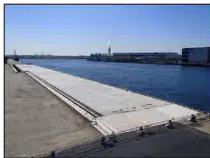
【岸壁：千鳥町2号岸壁の改修】
