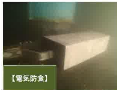
【岸壁：防食工による長寿命化】
