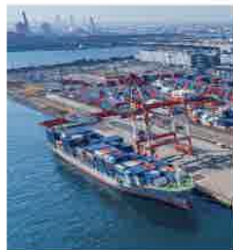
荷役機械 (ガントリークレーン)
