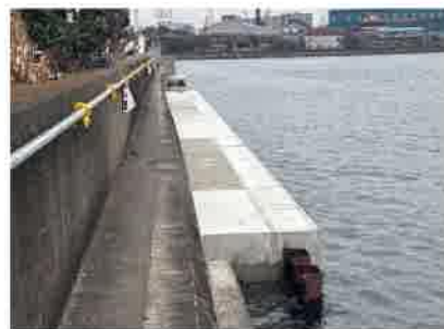
【護岸：老朽化した護岸の改良】
