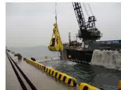
【泊地：水深確保のための維持浚渫】
