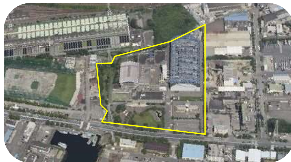
入江崎総合スラッジセンター
