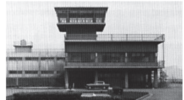
建設当時の入江崎水処理センター
