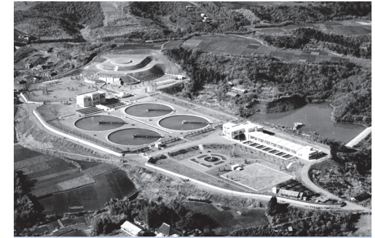
長沢浄水場(昭和29年当時)
