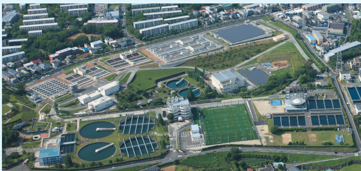
再構築実施後の長沢浄水場
