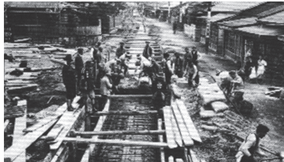
昭和初期の下水管きよの整備
