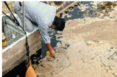
浮遊物の流出
