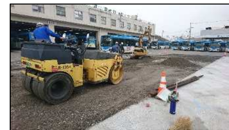
営業所車庫の路面補修
