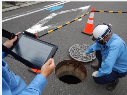
タブレットを用いた管さよの点検 (アセットマネジメント情報システム)
