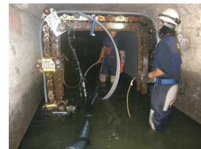
更生工法による施工の様子
