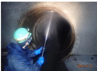
管きよ清掃状況
