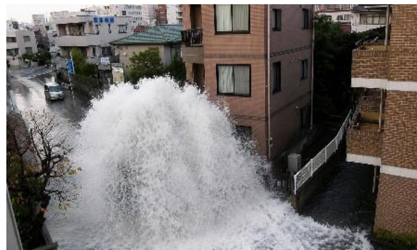
基幹管路の大規模漏水(平成21年12月・中原区)
