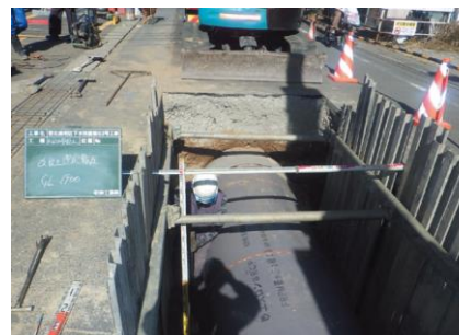
布設替工法による施工の様子
