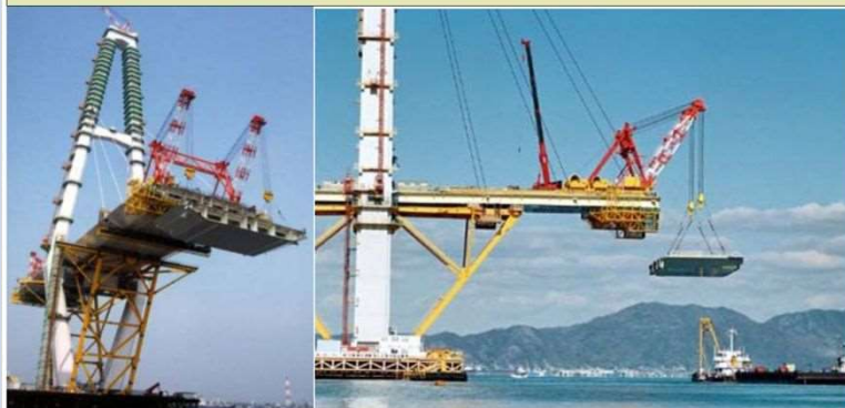
エレクショントラス(橋上鋼桁吊上げ機械設備) (イメージ)
