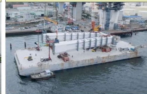
台船(主塔搭載状況)
