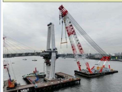
起重機船(架設状況)
