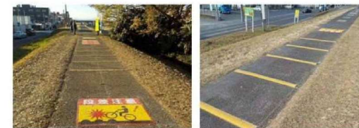
段差(スピードハンプ)
