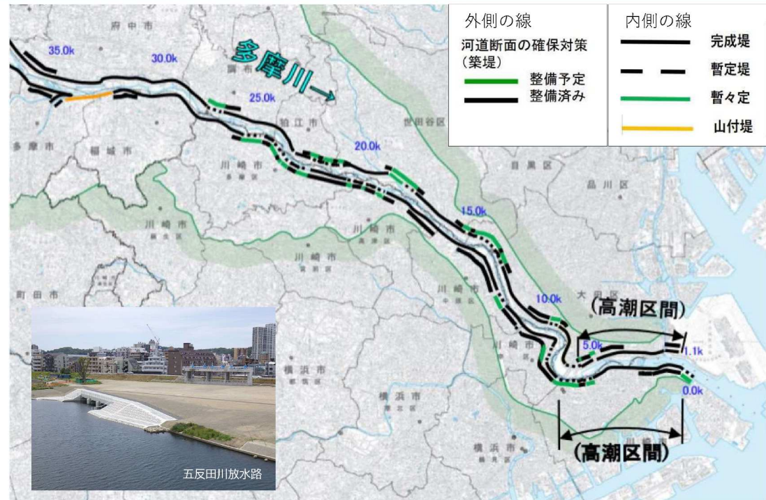
国の治水に関する整備状況 R7.1月14日(国土交通省京浜河川事務所)公表より一部抜粋
