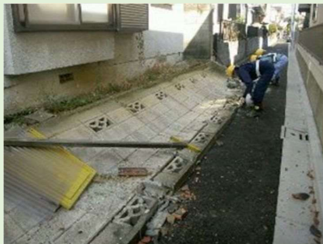
塀等の倒壊で道路が閉塞しやすい
