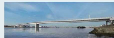
羽田連絡道路(多摩川スカイブリッジ)
