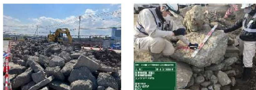
図-4 撤去したコンクリート殻の写真
