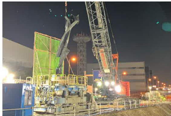
支障物(鋼矢板)
