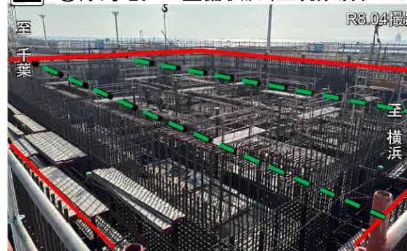
②浮島地区の整備状況(立坑鉄筋組立)
