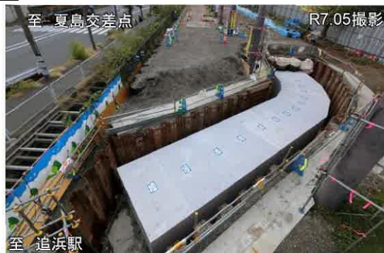
①福浦～夏島町地区の整備状況(水路移設工事)
