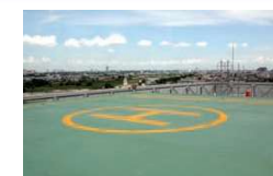
●屋上ヘリポート
