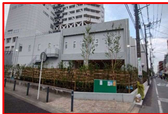
救 急 棟 【令和 8 年 8 月工事完了】
