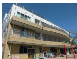
川崎区保育・子育て総合支援センター (令和元年9月開所)
