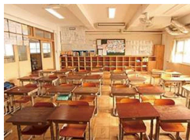
普通教室(木質化等の改修後)
