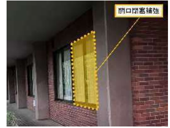
(大ホール棟の耐震補強)
