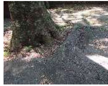
(根上がりによる通路の隆起) (池にヘドロが堆積)
