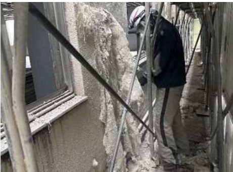
グラスファイバーメッシュ撤去の様子
