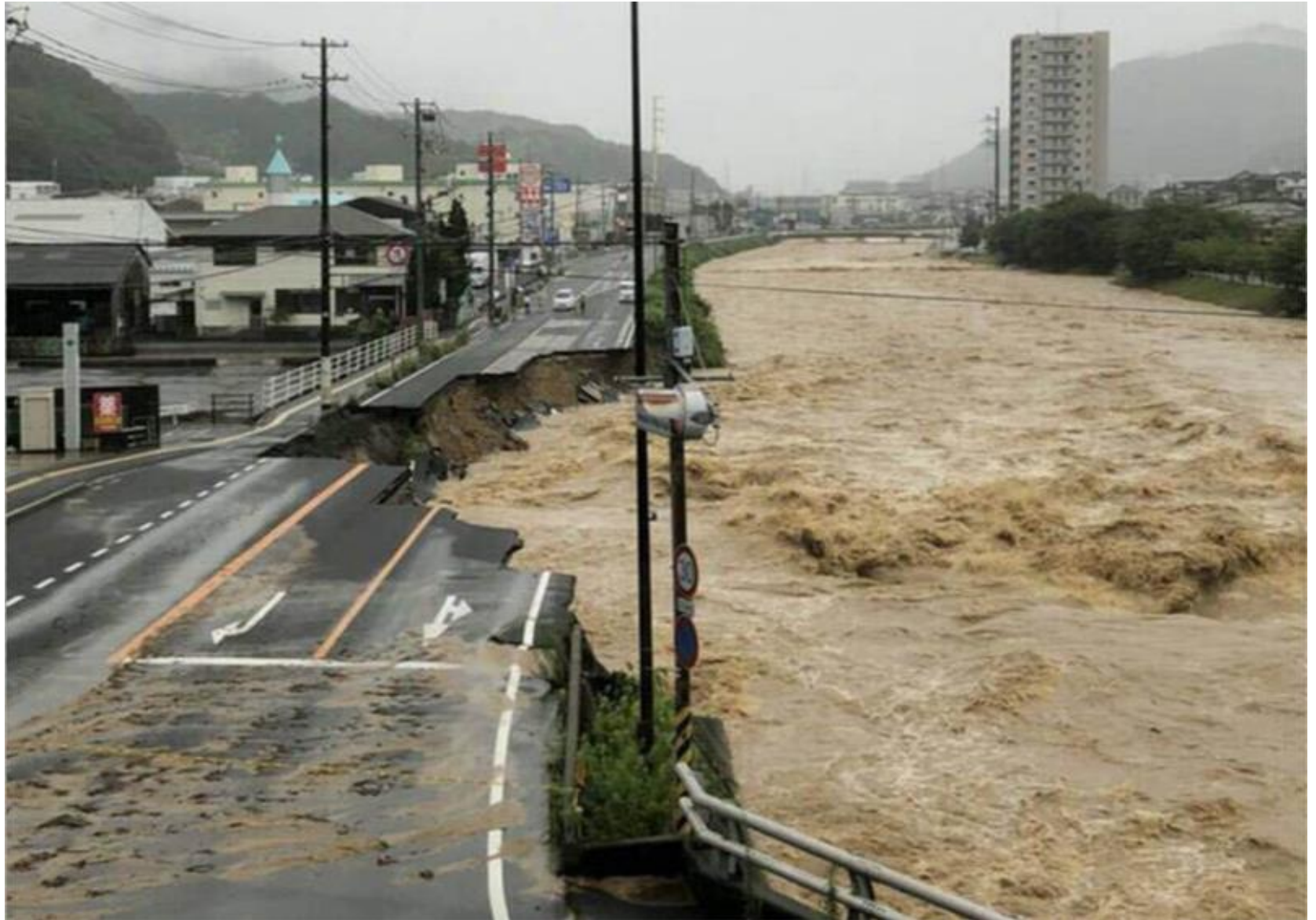
2018年7月豪雨による広島市安芸区での国道2号線被災現場 (写真提供：国土交通省中国地方整備局)
