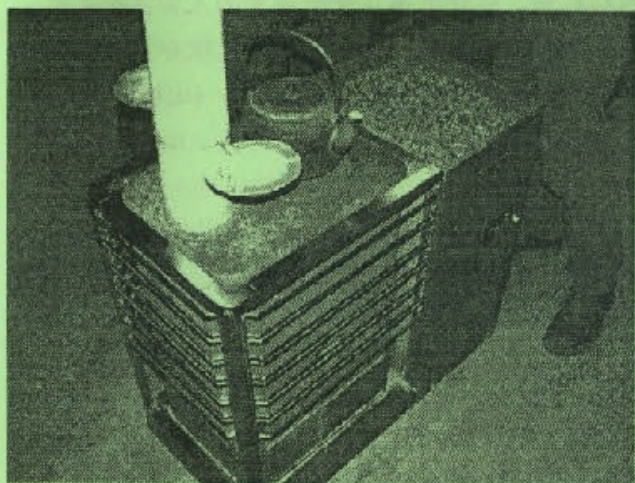
ペレットストーブ。右側のペレットが自動的におくられる。
