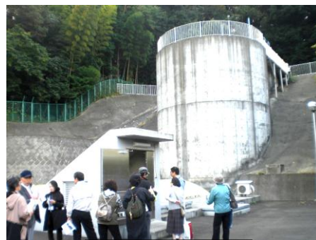
柿生水力発電所
