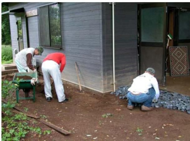
今回、その改良が計画され、排水に関しては、既存の排水桝に塩ビのパイプを接続し、そのパイプの先に、公園内に使われぬまま土に埋まっていた多数のU字溝を掘り出し、それを直線状に並べて繋ぎ、そこに向かって排水し、水が流れているうちに各U字溝の接続面の隙間からも浸透させる方式が考えられました。いっぽう、泥の跳ね返りについては、家の周辺に砂利を敷き詰めて防ぐ方策がとられる事になりました。
