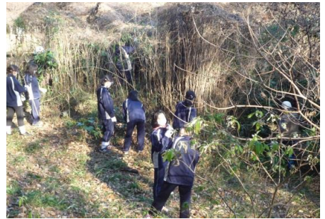
(蔦の除去作業)
