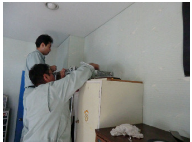
家具固定工事の様子
