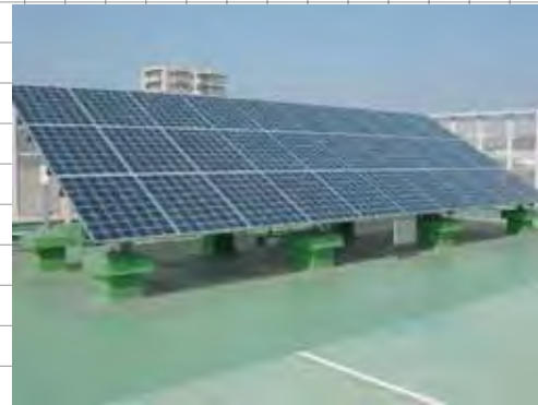
区役所屋上の太陽光パネル 5kW（多結晶系）
