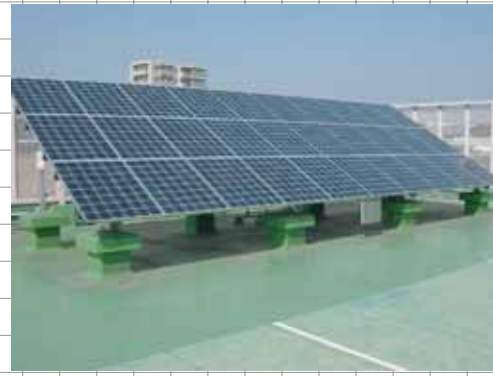
区役所屋上の太陽光パネル 5kW（多結晶系）
