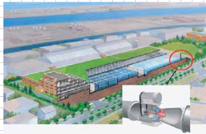
入江崎水処理センター西系完成予想図と小水力発電装置
