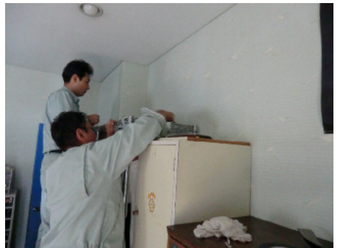
家具固定工事の様子
