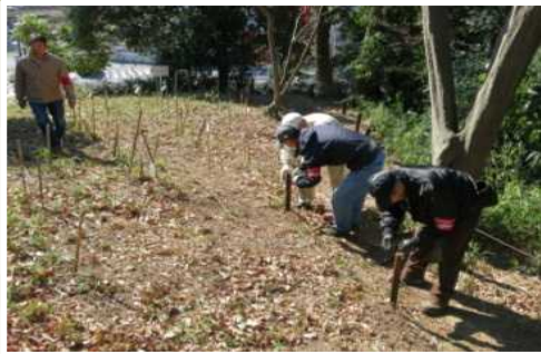
写真① 散策路のロープと杭の改修
