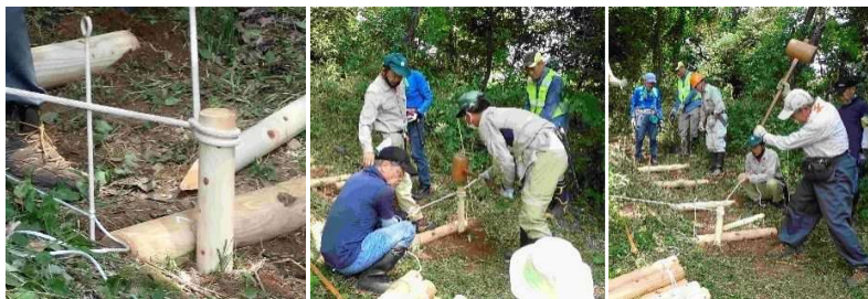
（写真左）杭打ち作業開始。杭が谷側に倒れたら、垂直になるように山側へロープを引いて修正。そのようにして最後まで杭をまっすぐに打ち込みます。（写真中央と右）かけやでの打ち込み作業は重労働。交代で作業するも蒸し暑いなか汗だくです。
