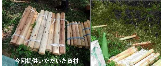
（写真右）等間隔に階段設置個所に細棒（串や枝）を立て、階段を仮置きしたところ。設置時の注意点として、丸太下部に隙間なく十分な土を敷くことが大事だそうです。
