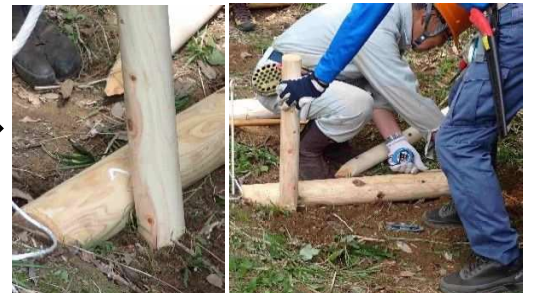
（写真左）打ち込む杭をマーキングした場所に立てる。（写真右）立てた細棒に張ったロープに対し丸太が直角になっているか、杭を打ち込む前に再確認しています。
