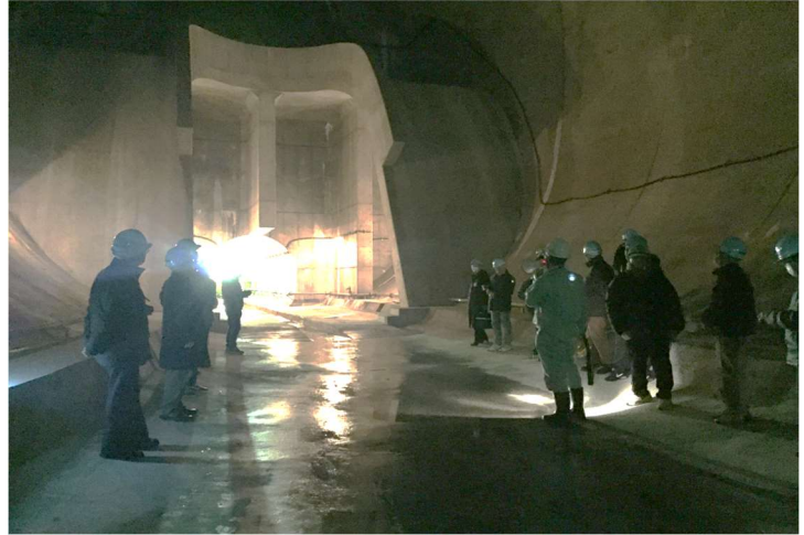
恩廻公園調節池
