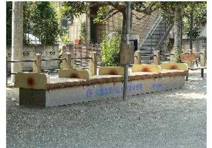
組立式の応急給水栓などの給水器具が格納されています。
