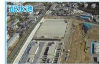
地震計が大規模地震を検知すると緊急遮断弁が閉まって配水池、配水塔の1池分の飲み水を確保します。
