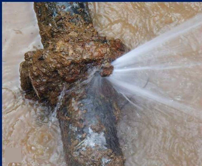
← 漏水した水で道路が陥没するなど、2次災害につながる恐れも。
