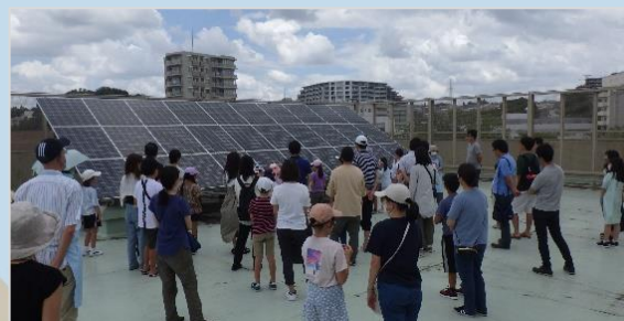
麻生区役所屋上の太陽光パネル
