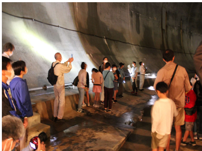
恩廻公園調節池
