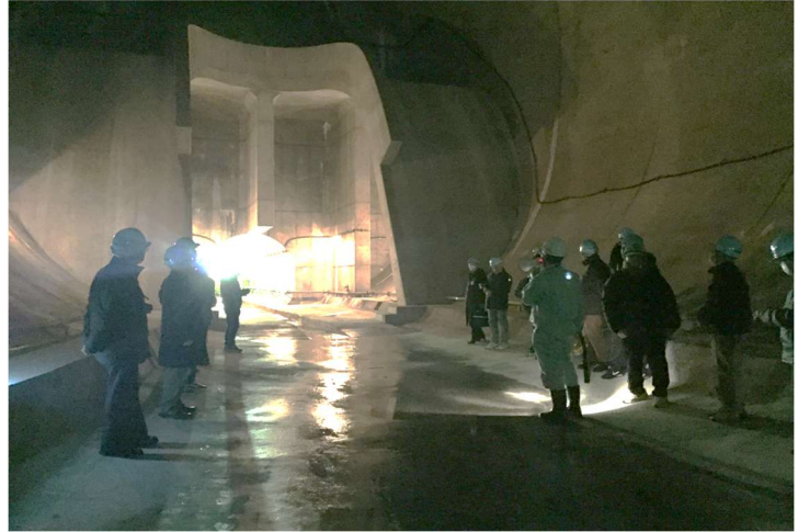
恩廻公園調節池
