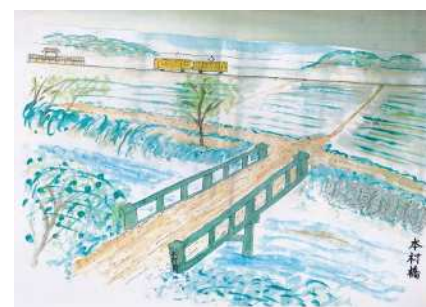
昭和初期の頃の本村橋。まだ木製 の橋であった。
