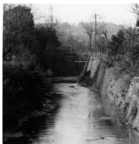
ぶらぶら橋と思われる吊り 橋。個人用のものであった。
