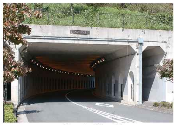
トンネル内は死角が多いので注意しましょう。
